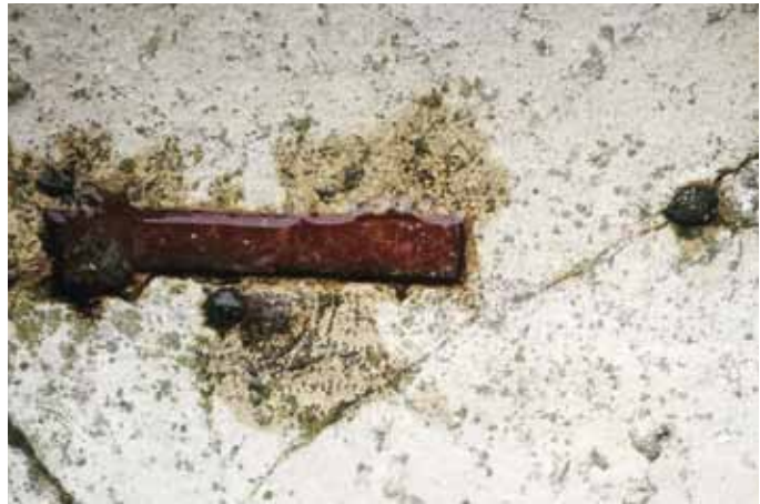
Particolare del basamento in pietra che circonda il chiostro con fori di sede a testimonianza di un'antica cancellata.
