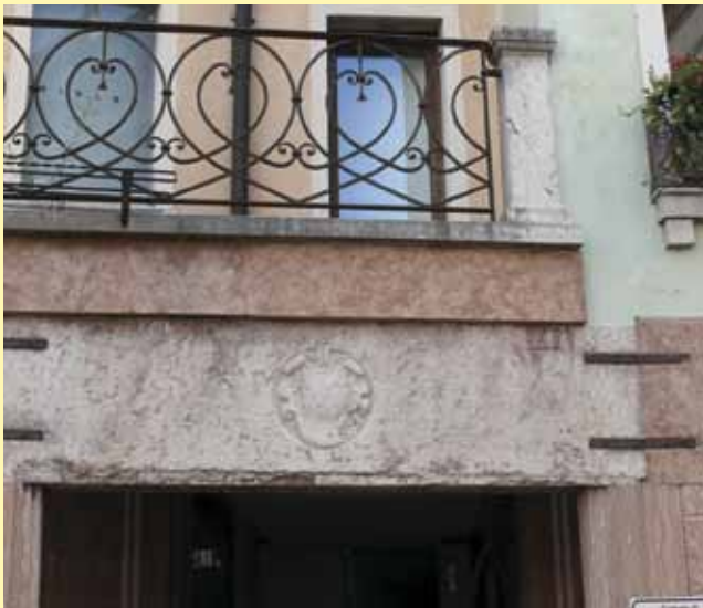
Parapetto in ferro battuto a mano da Gianpaolo Basei, pietra lavorata dalla ditta Faena Marmi, Piazza Vittorio Emanuele, Belluno.
