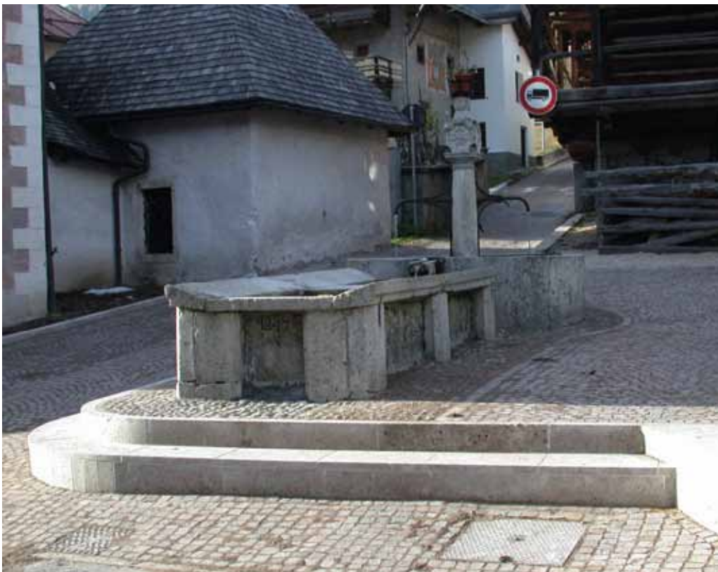
Fontana lavatoio in pietra dolomia datata 1847 in Agordino. Pulizia della struttura, recupero e rifacimento della pavimentazione a cura della ditta Sevis di Moena (foto Sevis).
