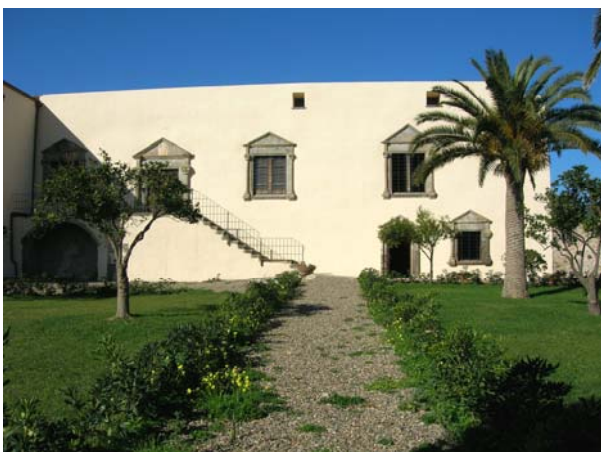
fig. n. 3 – Barumini, casa Zapata , XVII secolo.
