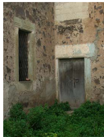
fig. n. 6 – Seneghe, casa privata, riutilizzo di antiche architravi.
