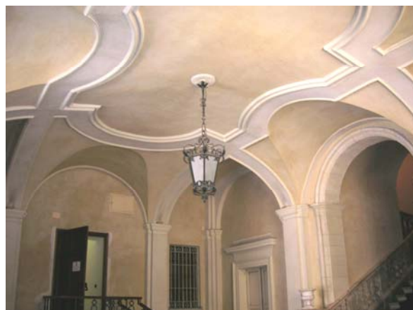
fig. n. 5 – Cagliari, palazzo viceregio , volta planteriana del vestibolo, ingegneri Luigi Andrea Guibert e Antonio Felice de Vincenti.
