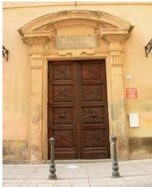
figg. n. 2-3 – Cagliari, complesso culturale del Balice , particolare dei portali.
